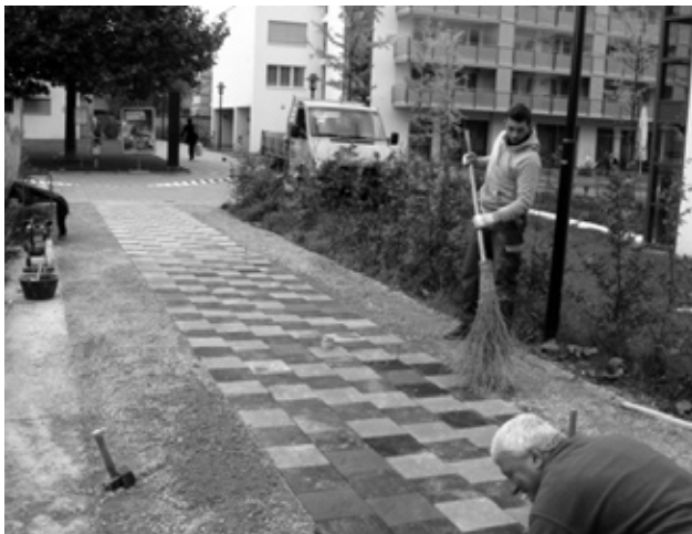
Fertigstellung des Plattenbelags beim Seepark.
