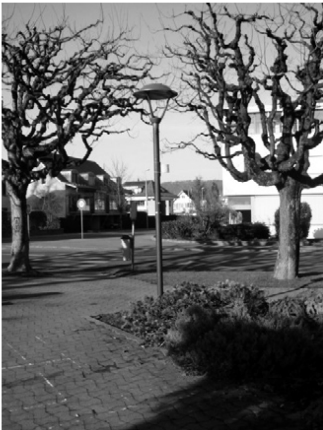
LED-Leuchte beim Fussweg Hubelstrasse-Winkelweg.
