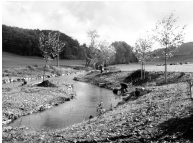
Neuer Wasserteiler Worble/Mühlekanal
