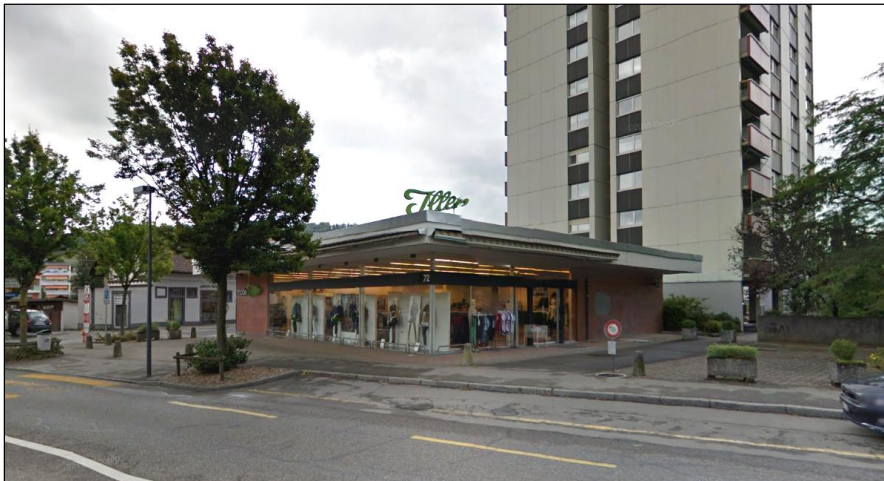
Bild 2: Ansicht Bernstrasse 72 (aktueller Zustand)
