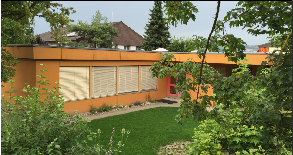
Abbildung 18: Kindergarten Dennigkofenweg 197 - heutiger Zustand
