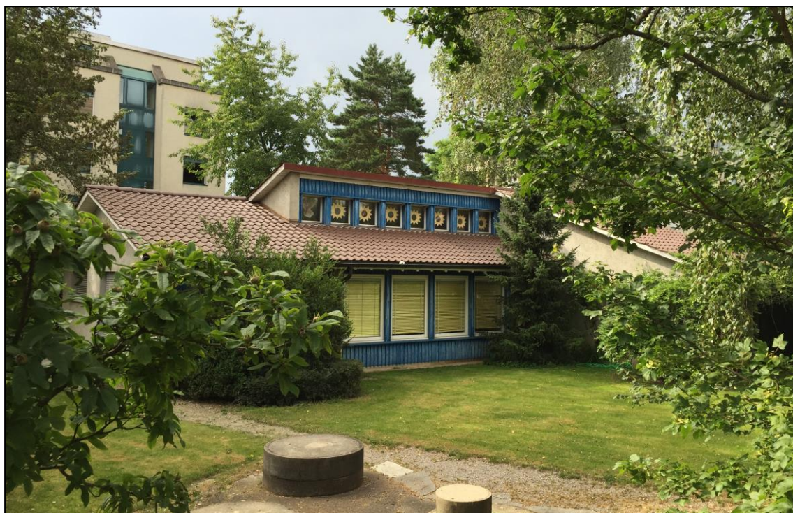
Abbildung 9: Kindergarten Alpenstrasse 14 - heutiger Zustand
