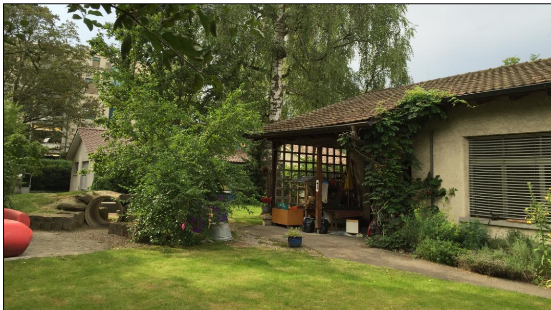
Abbildung 8: Kindergarten Alpenstrasse 12 - heutiger Zustand
