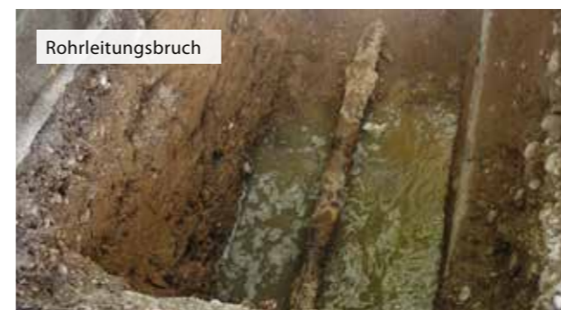
Rohrleitungsbruch eines Zementrohrs
