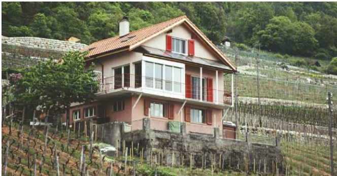
Solaranlage an Fassade
