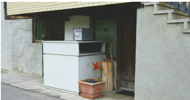
Baubewilligungspflichtige Luft/Luft-Wärmepumpe mit Luftbezug ausserhalb des Gebäudes
