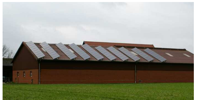
Aufgeständerte Solaranlage (&gt; 20 cm)
