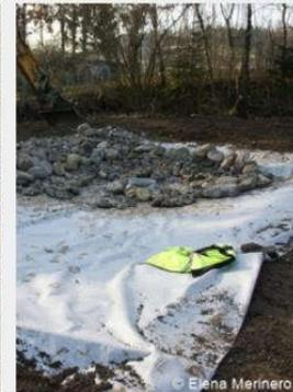
Aufbau eines Folienweihers mit Vlies, Folie, Vlies und Substrat (vgl. die Hinweise zu den unterschiedlichen Erfahrungen zu einem Vlies über der Folie).
