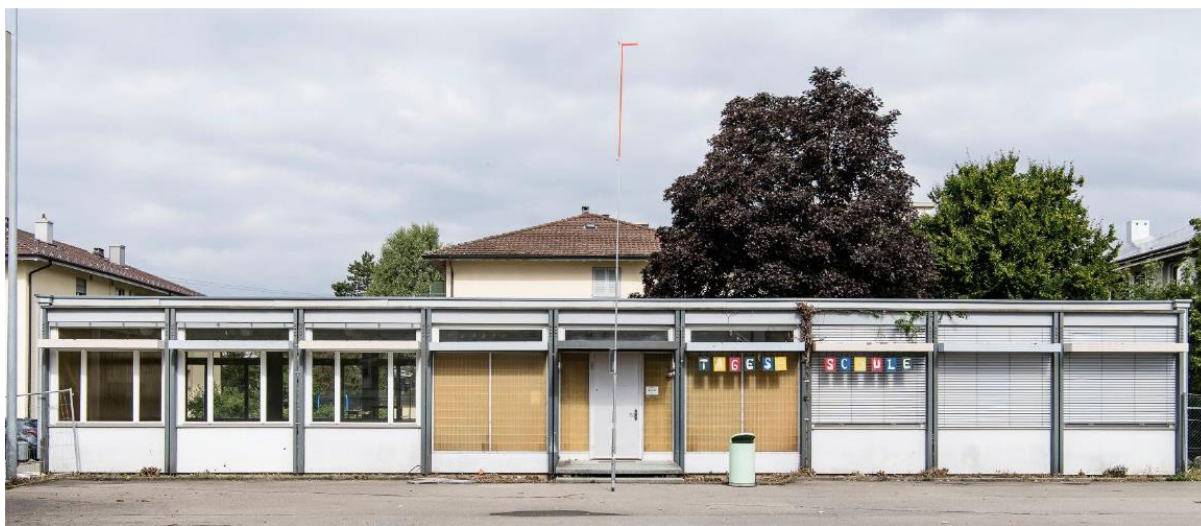
Abbildung 2: Foto Eingangsfassade Variel-Pavillon
