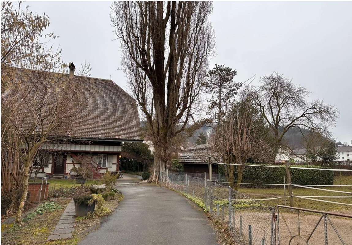
Abbildung 41: Westfassade mit Zugang zum Wohntrakt und Garten
