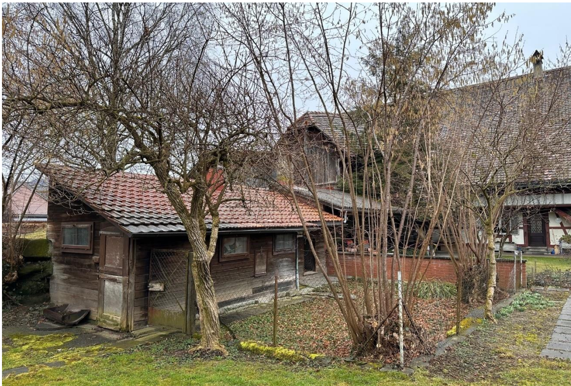
Abbildung 43: Westfassade mit Anbau an Tenn-Auffahrt
