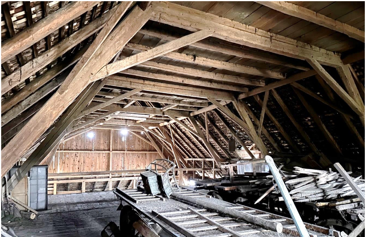
Abbildung 47: Dachgeschoss Blickrichtung Nordfassade
