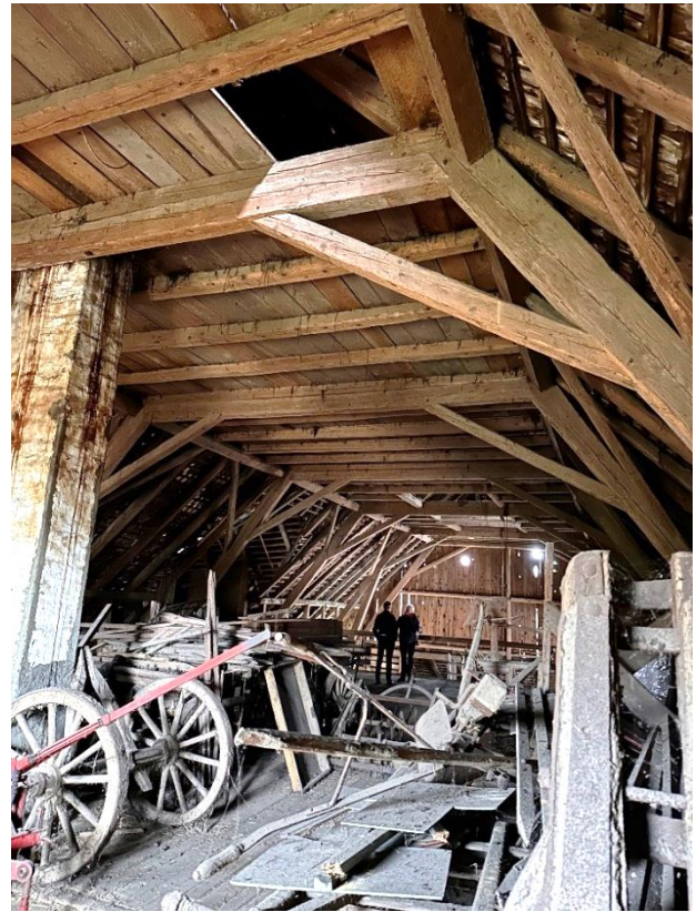
Abbildung 46: Dachgeschoss Blickrichtung Nordfassade
