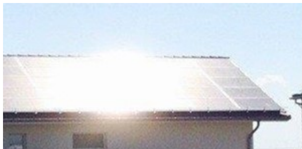
Abbildung 7: Blendwirkung von einem Schrägdach. Deutlich sichtbar ist die Bündelaufweitung, dadurch erkennbar, dass anstelle des direkten Abbilds der Sonne eine flächige Lichterscheinung sichtbar ist.
